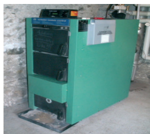
Zentralheizungskessel
